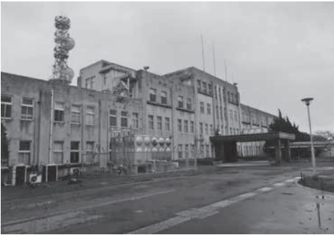
旧鹿屋基地司令部 (近く解体予定)
