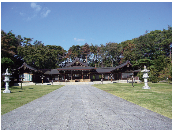
長野県護国神社本殿
