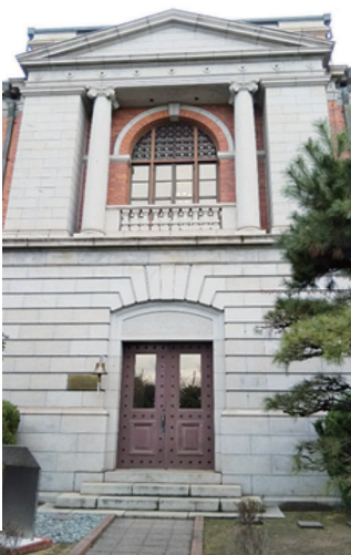
海側ファサード
