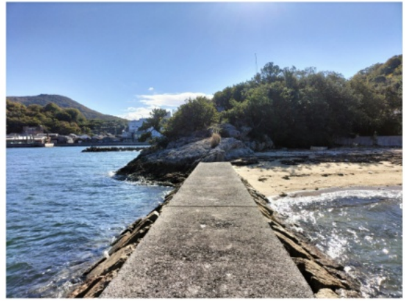
唯一当時のままの姿をとどめている栈橋の突端(海側)から基地跡を撮影。写真の左遠方が、蛟龍繫留跡地付近。
