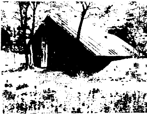
復元された三角兵舎
