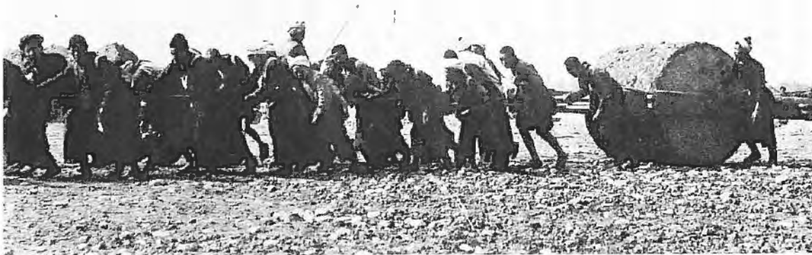
成都における飛行場建設
