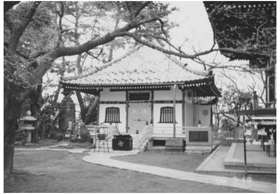
改修された特攻平和観音堂 右側は本殿
