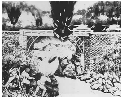
滑空歩兵第1聯隊作業中隊がルソン島 イリサン西方で橋梁爆破し敵戦車を阻止
