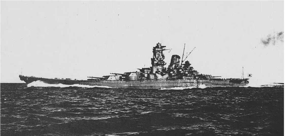
昭和16年10月30日、宿毛湾沖標柱間で全力公試運転中の大和（その3）——ワシントン海軍軍縮条約による海軍休日の期限終了を迎えて、日本海軍が建造した戦艦大和型のネーム・シップである。史上最大の艦砲である45口径46センチ砲を9門搭載、同砲弾に対する十分な防御を備え、速力27ノットを発揮、基準排水量は64,000トンに達し、人類がつくりあげた最大、最強の戦艦であった。なお、この時の状態は69,304トン、151,700軸馬力、27.3ノットである。
