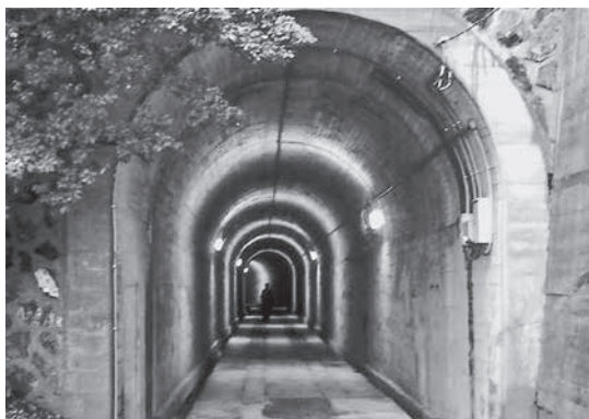
トンネル入口
