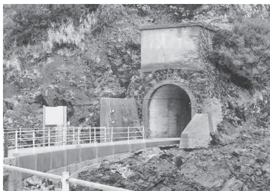
トンネル出口
