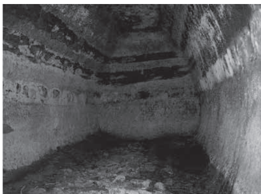
写真5 桜花格納隧道跡・房総東部行川基地
